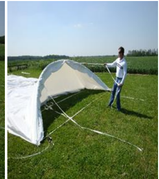
Élévation de la première baleine à 45°
